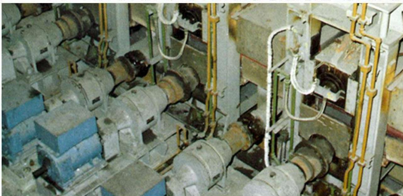
Reductores planetarios FELLAR para accionamiento de pinch roll de c.c. de blooms.
